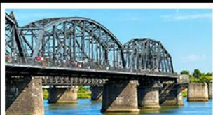
สะพานหวาดถานตง
