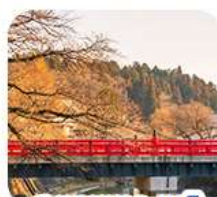
สะพานนากะบาชิ
