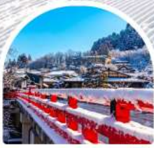
สะพานนากะบาชิ
